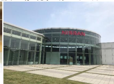
▲ゲストホール(外観)
